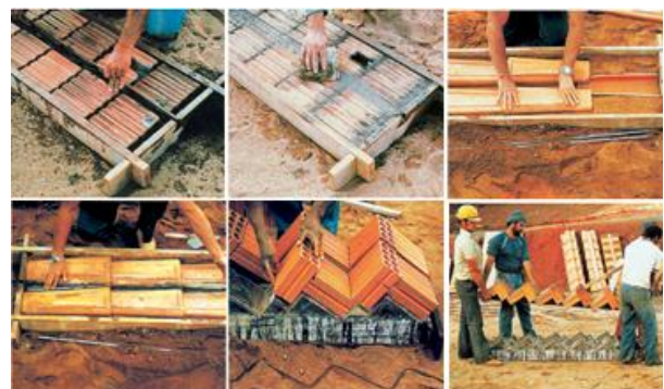
Fig. 4.2.5 - Placas cerâmicas utilizadas na construção do conjunto.
