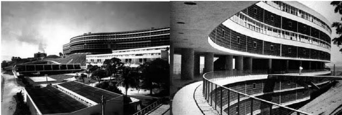
Fig. 4.1.1 - Fotografias do Conjunto Habitacional Pedregulho. Fonte: Acervo Carmem Portinho
